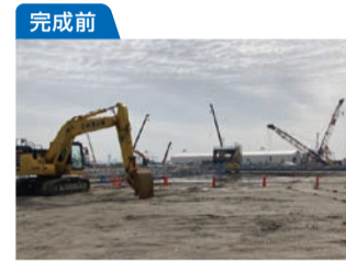
建築工事の様子
